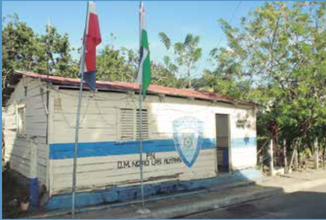
Así encontramos el Destacamento Nizao, Las Auyamas
