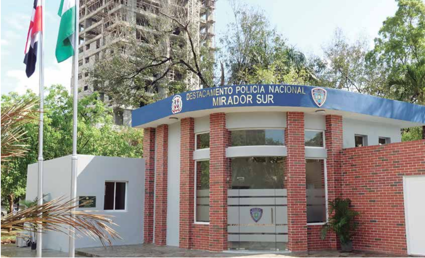
Destacamento policial Mirador Sur (D.N.), Dirección Central del Distrito Nacional. Construido en colaboración con el Banreservas.
