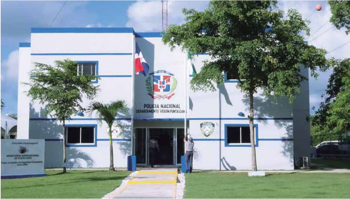
Inspectoría de Verón (Punta Cana), Dirección Regional Este. Construido en colaboración con el Grupo Punta Cana.
